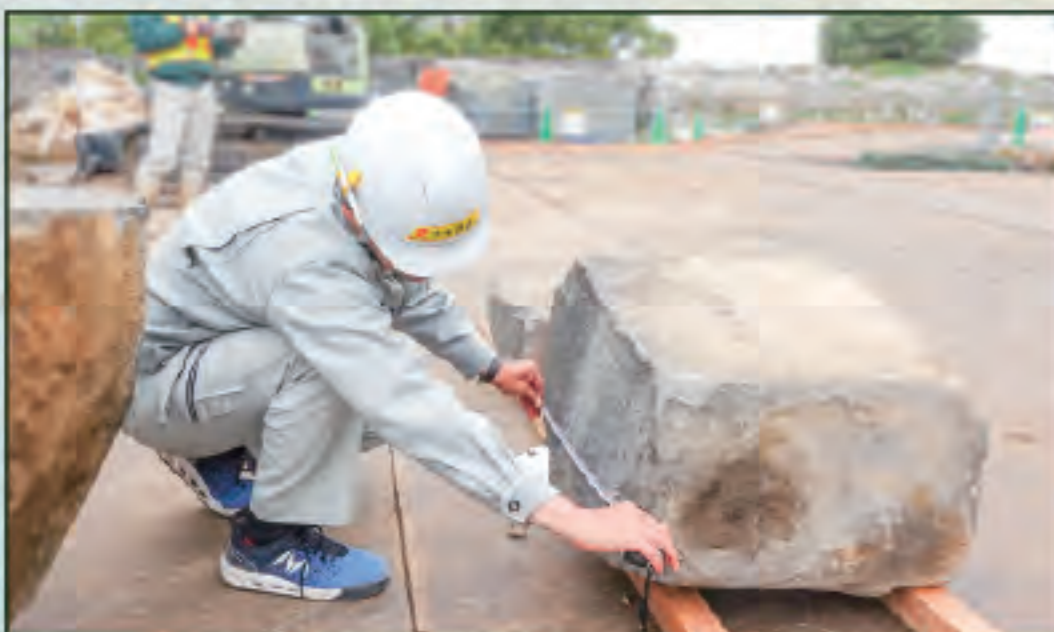
石垣の石材調査〈熊本城〉
