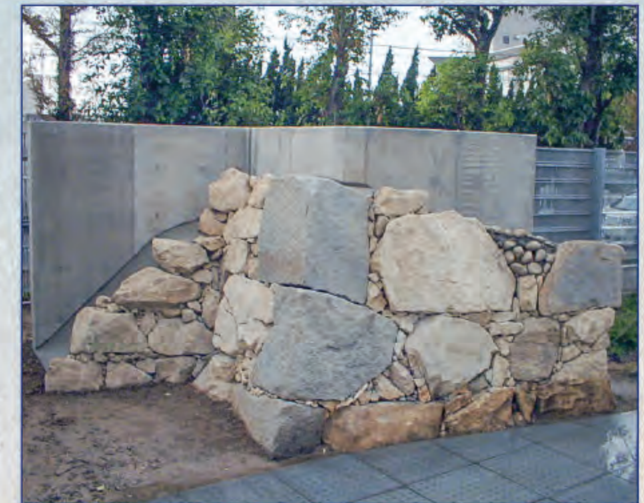
萩原旧堤防跡出土石垣移設復元 (八代市立博物館未来の森ミュージアム)
