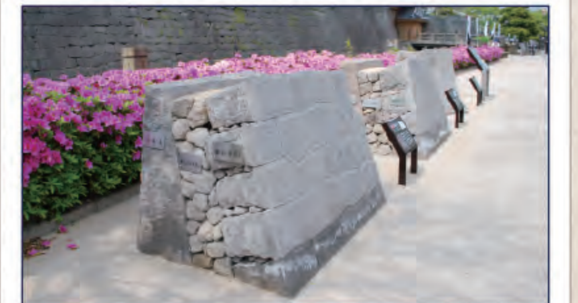
構造展示物の整備(鹿児島県鶴丸城跡)
